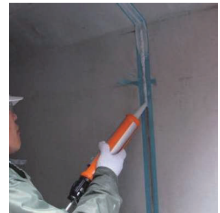
目地部への施工（内面から）
