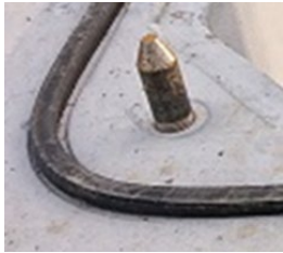
① ガイドピンに合わせて部材を据付
