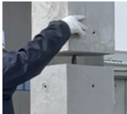
① ガイドピンに合わせて部材を据付
