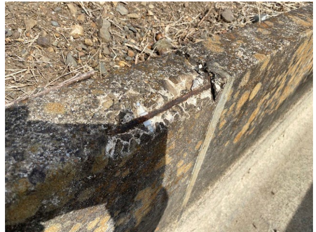
写真. 鉄筋が腐食し、表面のコンクリートが剥落した状況
