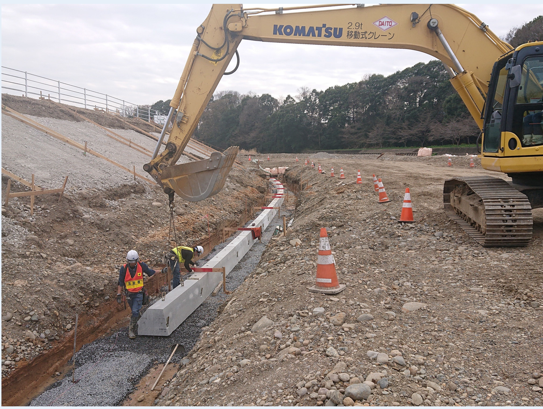
①法留ブロック設置
