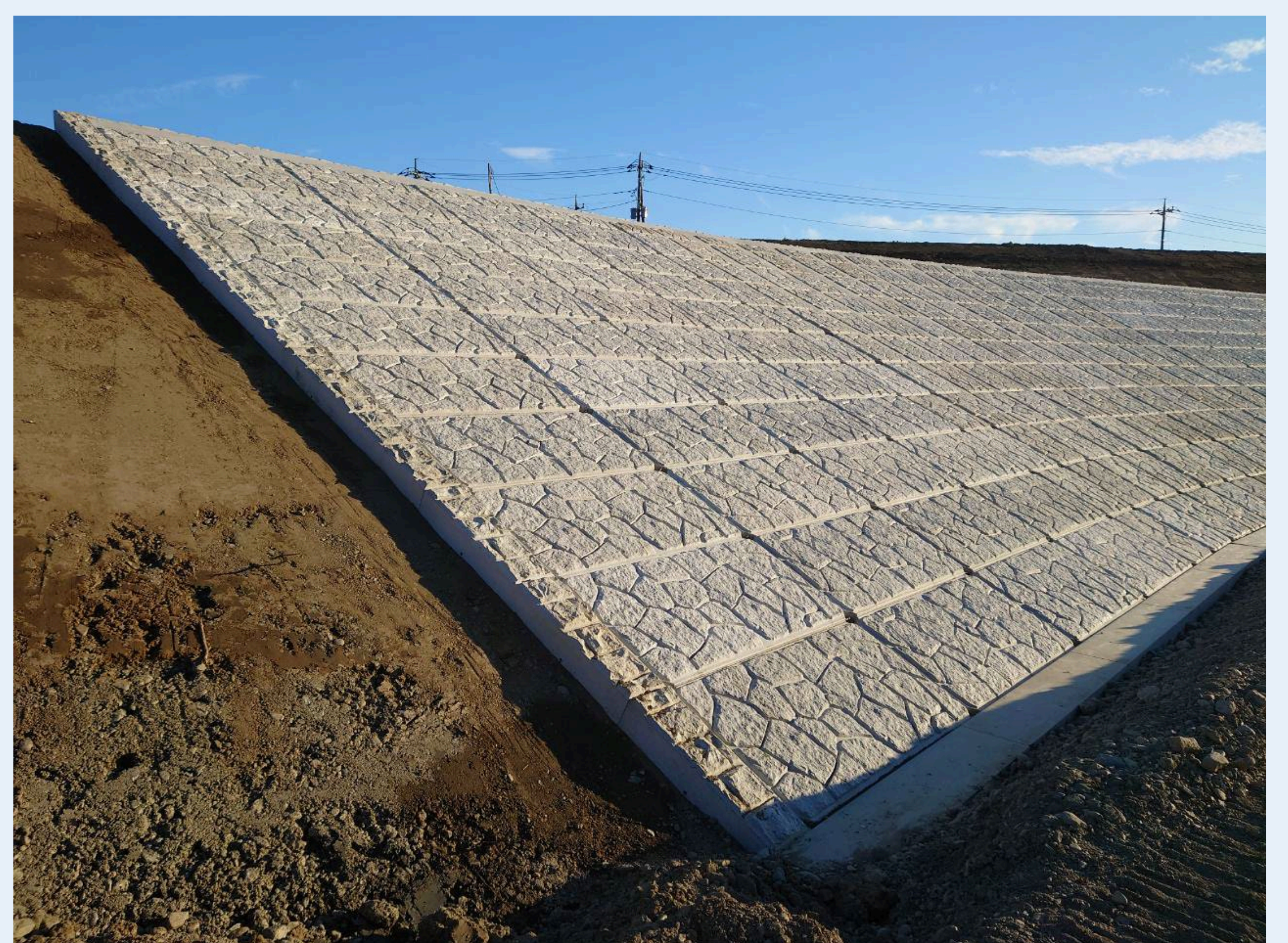
⑧施工完了
