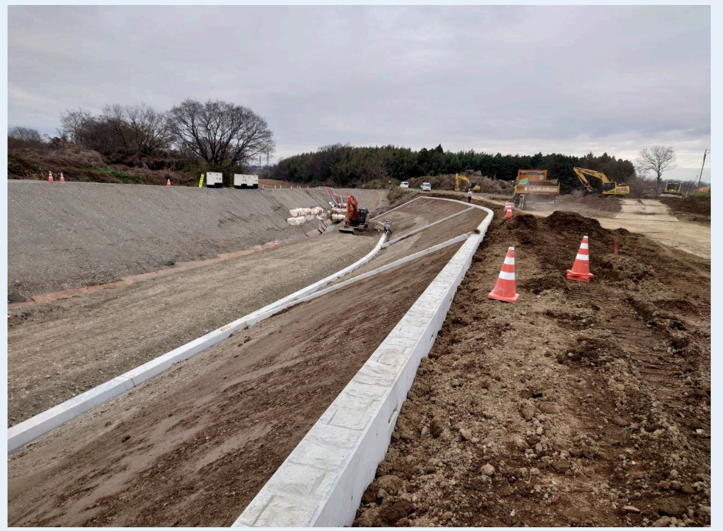
②帯工ブロック設置
