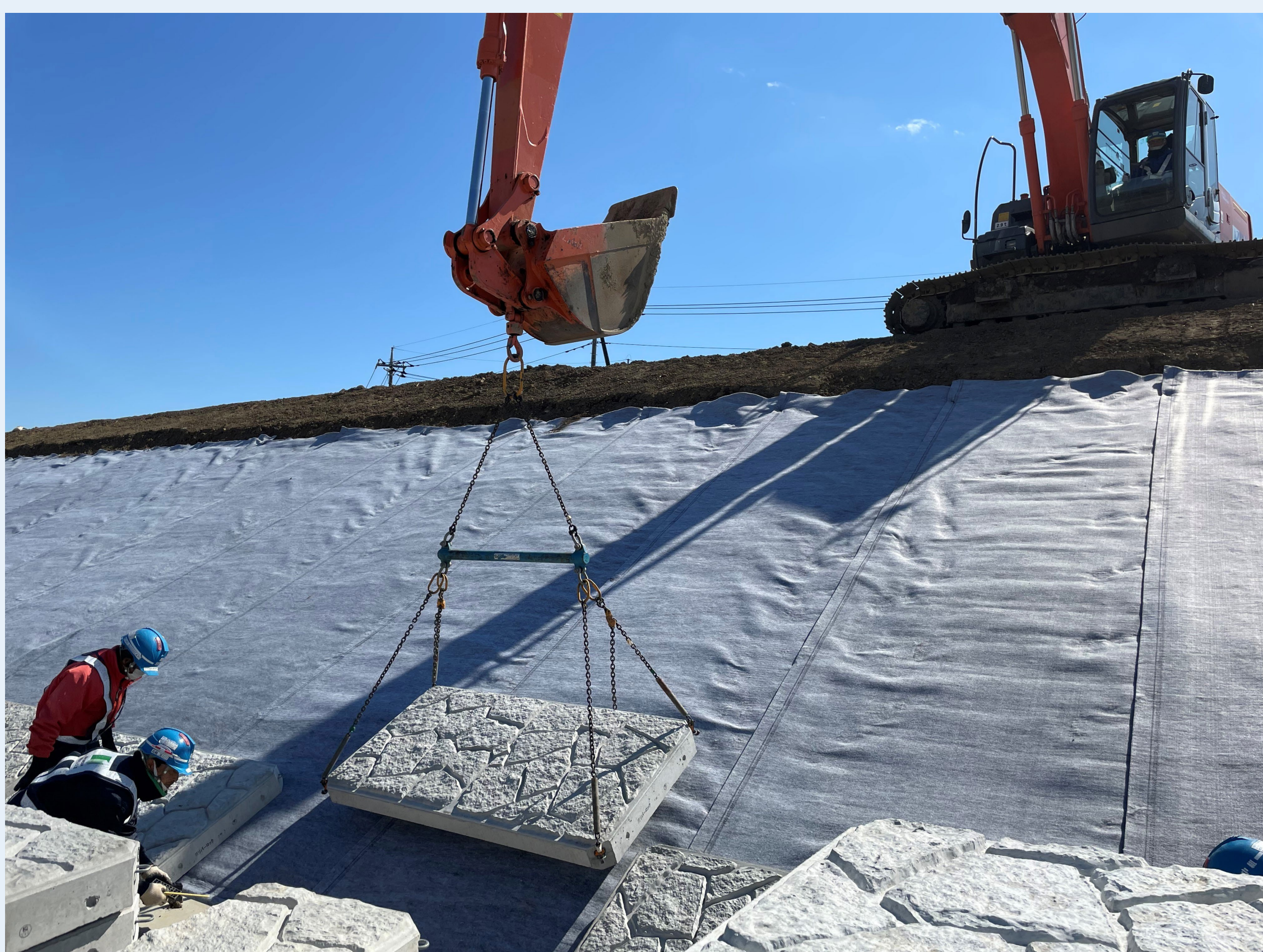
⑤専用吊具使用状況
