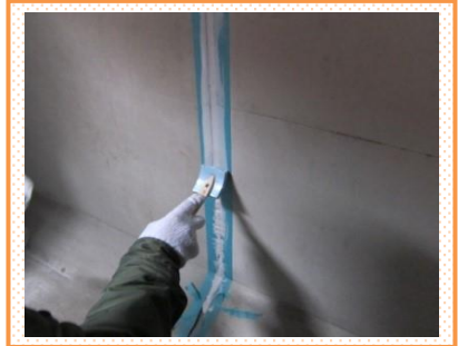
▲シーリング材充填工
