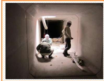
▲ボックスカルバートの施工写真
