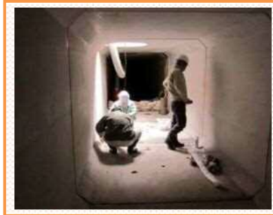
▲ ボックスカルバートの施工写真
