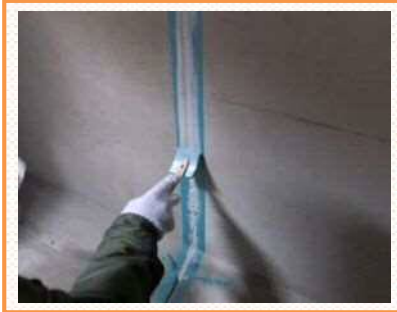
▲ シーリング材充填工
