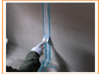
▲シーリング材充填工
