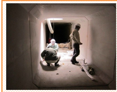
▲ボックスカルバートの施工写真
