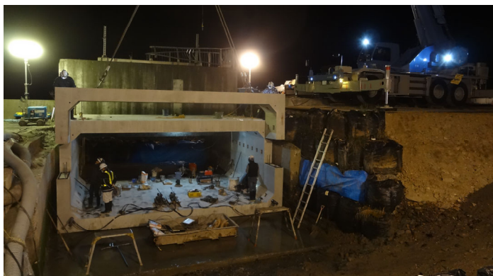
宮城県南三陸町 二分割ボックス B7600×H2600×L1000 夜間施工で工期短縮の観点からPCa化
