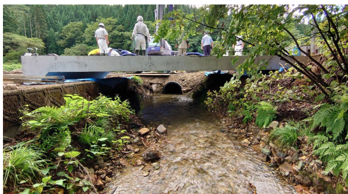
秋田県鹿角市 門型カルバート B8500×H1000×L1000 既設の河川ブロックを供用したまま施工
