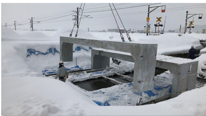
秋田県大仙市 門型カルバート B8000×H1700×L1000 独立基礎もPCa化、悪天候下でも安全に施工
