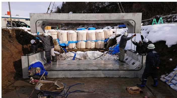
青森県大鰐町 二分割ボックス B5000×H1300×L1000 冬季施工で工期短縮の観点からPCa化
