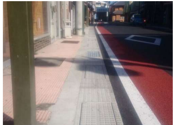
桜川市 真壁町地内排水整備工事
